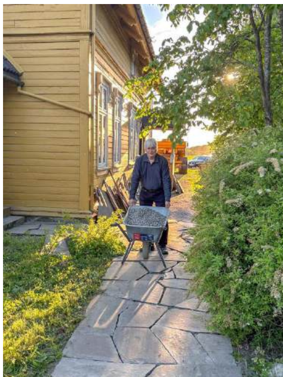
Kjell Sand i full gang med hellelegging. (Gylmer Bach)
